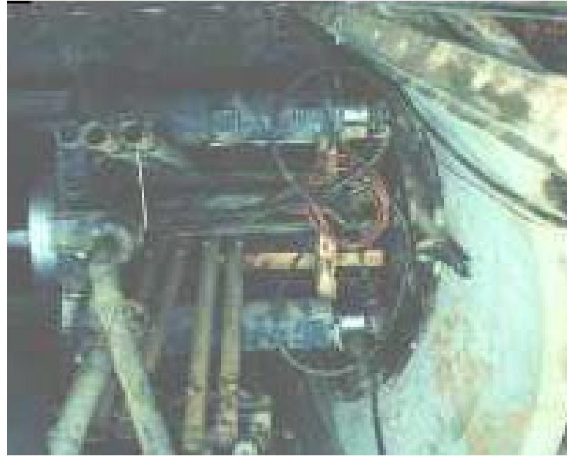
Die Vortriebsarbeiten wurden mit Tagesleistungen von 12-15 Metern pro Schicht durchgeführt.
