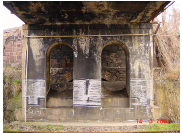
Ansicht alte Widerlagerwand
